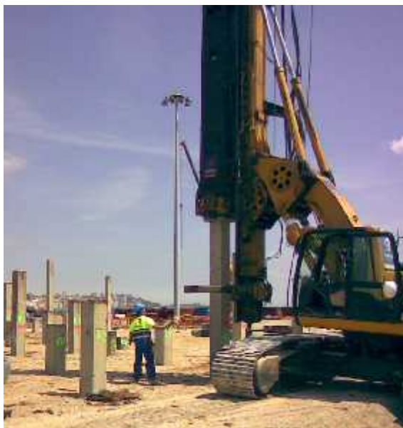
Fig. 1: hincado de pilotes prefabricados
