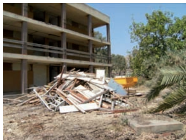
Foto 2. Separación previa en origen de residuos de construcción y demolición, RCD.
