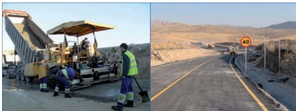
Foto 5. Tramo experimental en la carretera A-367. Venta El Cordobés. A la izquierda extendido de gravacemiento reciclada, a la derecha aspecto del tramo una vez asfaltado.
