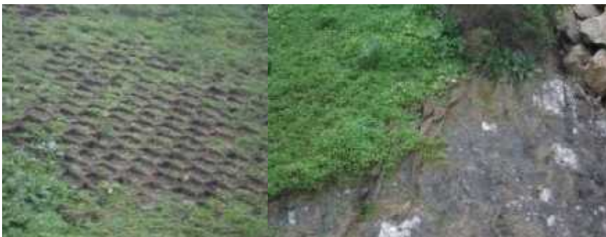
Foto 1: Variaciones en la pendiente y naturaleza del sustrato en un mismo talud, y su incidencia sobre la eficacia de unas geoceldas colocadas sobre él.
